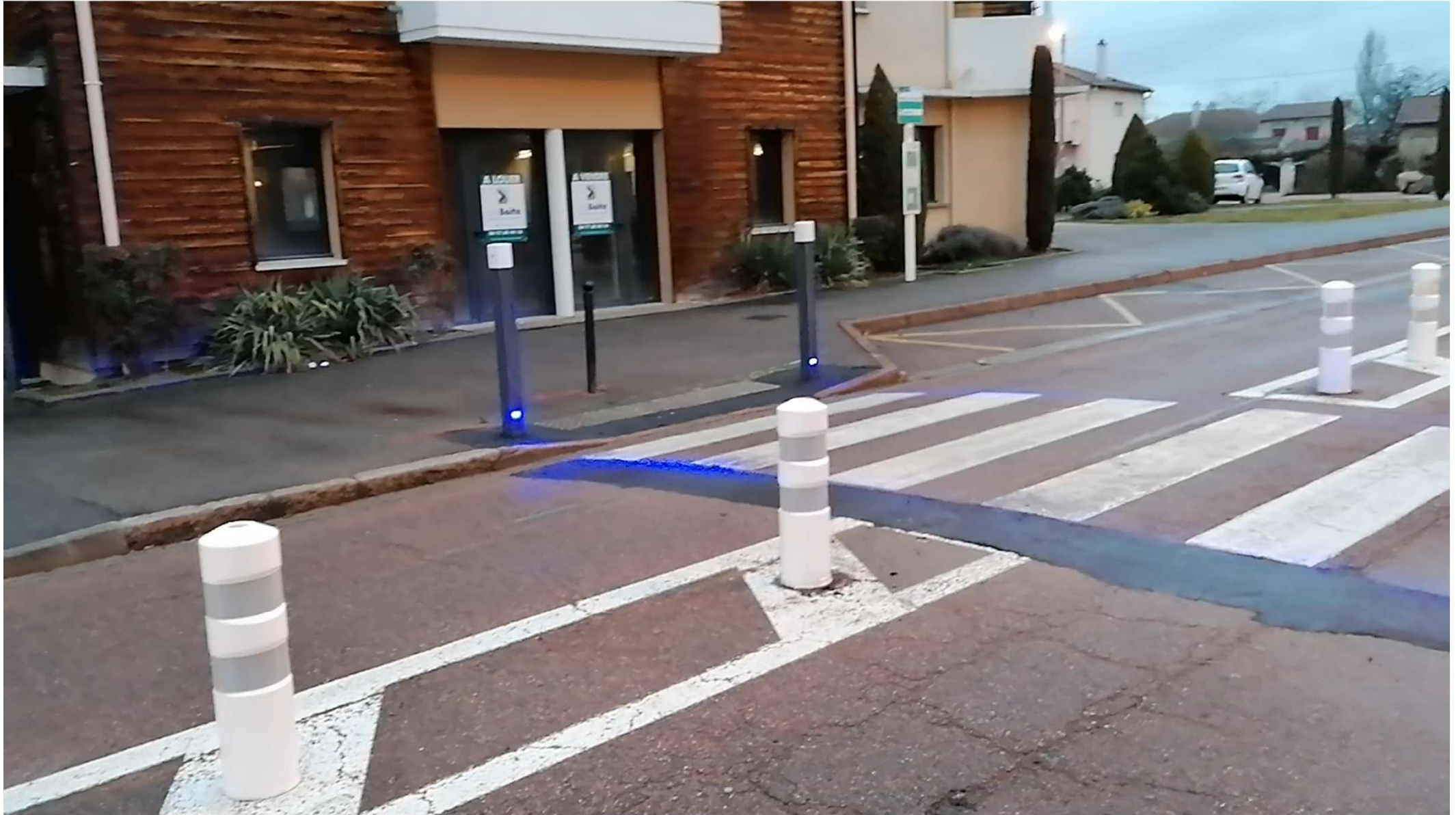
Mise en place de passage piéton lumineux
