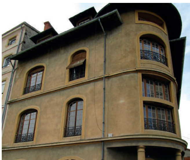
Façade en ciment naturel prompt
