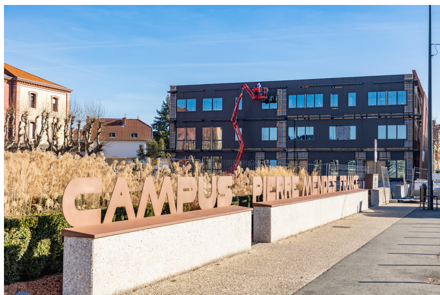
I Bâtiment en construction près du Campus
