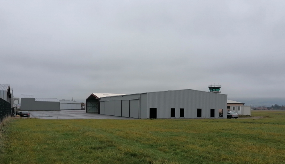
Construction hangar hôtel |
