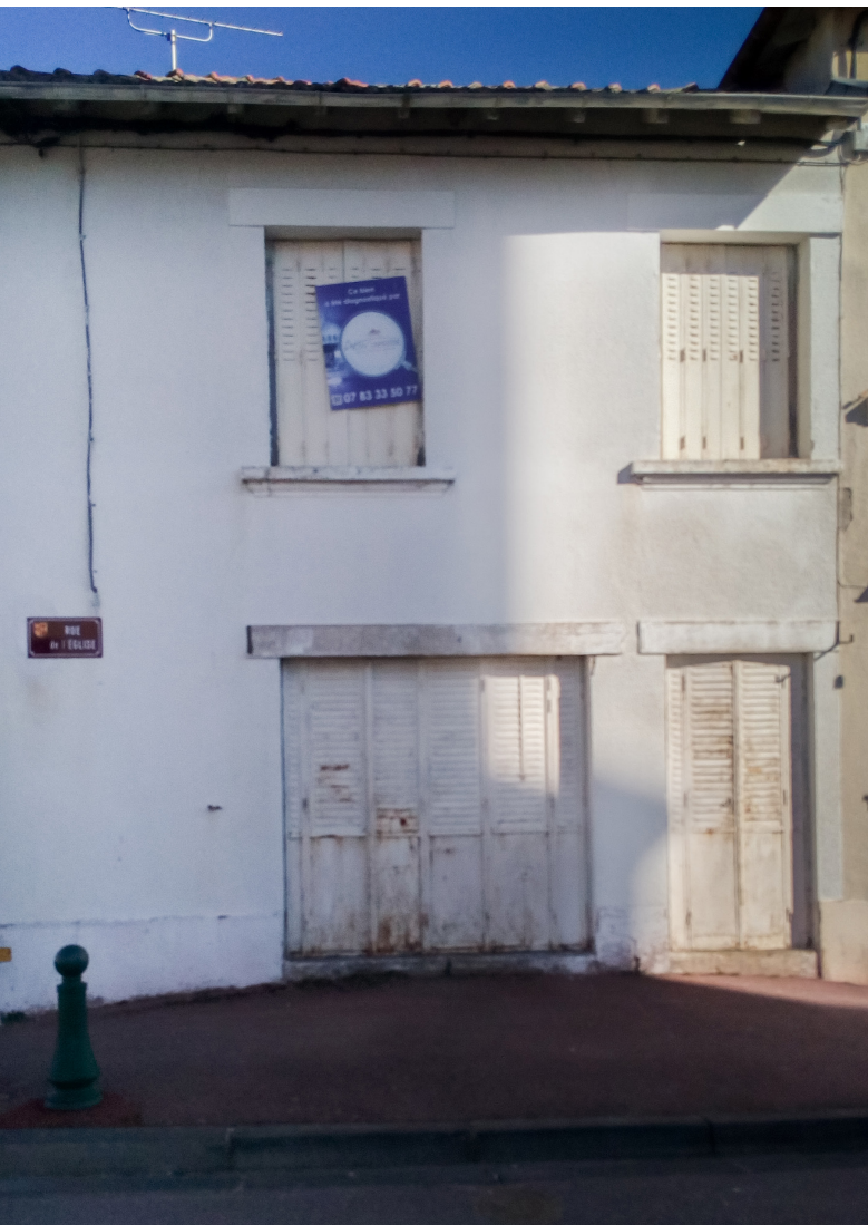
| Logement vacant avant travaux
