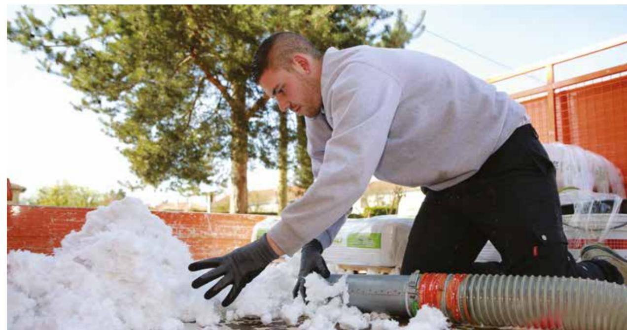
*Pour isoler les combles, la laine minérale en flocons est aspirée puis expédiée par un tuyau vers le toit pour être ensuite soufflée.*
