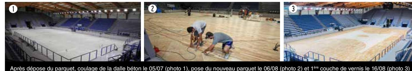
Après dépose du parquet, coulage de la dalle béton le 05/07 (photo 1), pose du nouveau parquet le 06/08 (photo 2) et 1<sup>ère</sup> couche de vernis le 16/08 (photo 3)
