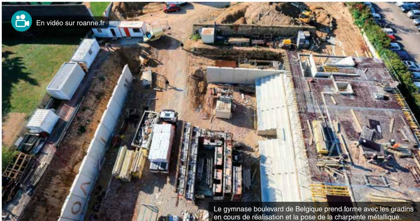
Le gymnase boulevard de Belgique prend forme avec les gradins en cours de réalisation et la pose de la charpente métallique.
